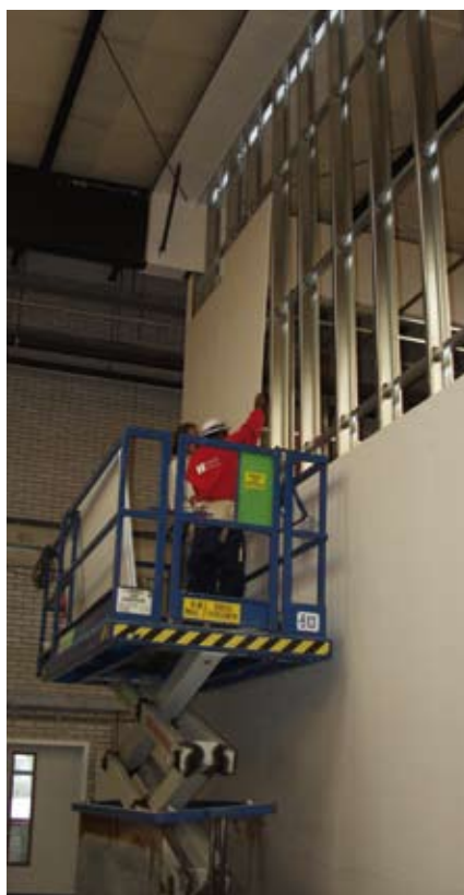
Cloison coupe-feu grande hauteur Promat®-SYSTEMWALL
