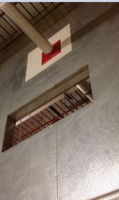
Cloison DURASTEEL® et calfeutrement coupe-feu
