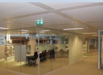
Cloisons vitrées coupe-feu Promat®-SYSTEMGLAS
