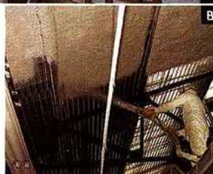
B Le DTU n'autorisant pas la projection de laine minérale sur bac acier, celle-ci se fait sur treillis métallique accroché à une ossature secondaire. (Doc Eurisol)
