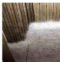
Mousse de fibres 9 000 m 3 d'ouate de cellulose liée au latex à la Cité de l'histoire de l'immigration. (Doc. Isoprojex)
