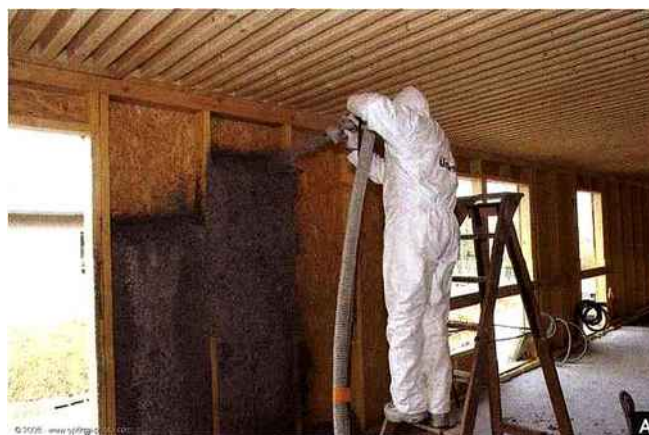
A Un bon projecteur d'ouate de cellulose peut appliquer jusqu'à 25 cm d'épaisseur en une seule couche. (Doc Univercell)
