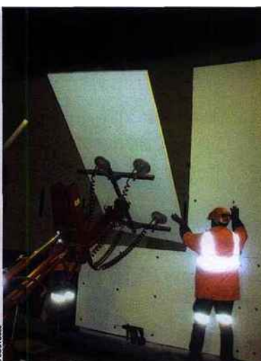
Pose assistée d'un robot
