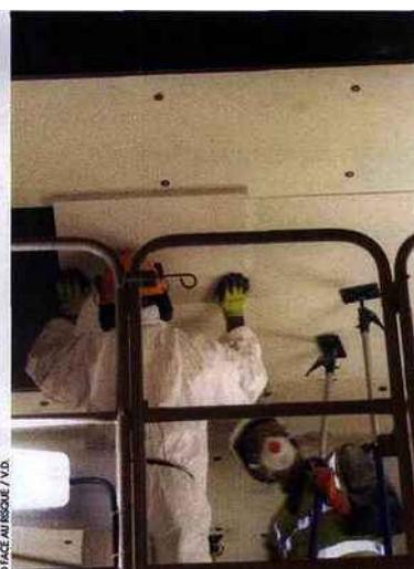
Pose manuelle entre les poutres du tunnel
