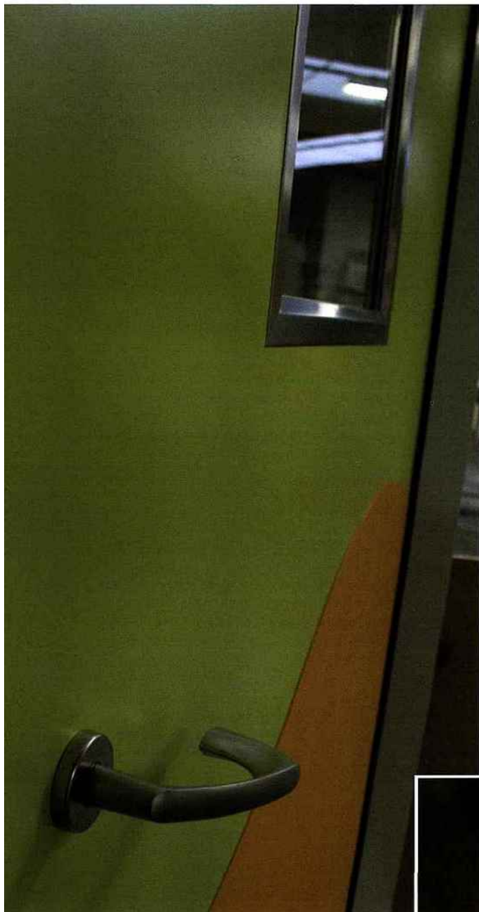
Mo219b = parecloses d'oculus affleurantes et protections des chants sur porte coupe-feu simple action
