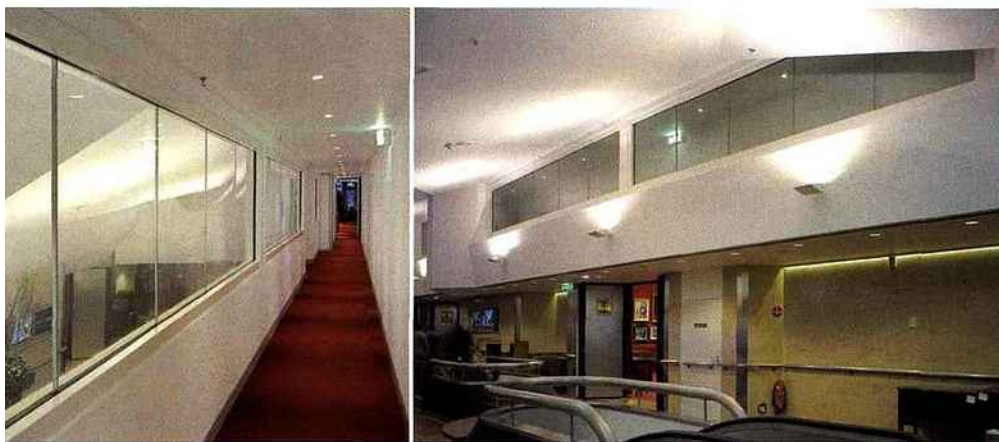
Cloisons vitrées bord à bord sans montant intermédiaire CF 90 coupe-feu 1 h 30 reliées par des joints silicone translucide. Ici à l'hôtel des ventes Drouot à Paris
