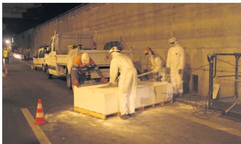
LA DÉFENSE, JEUDI SOIR. Quatre nuits par semaine, le tunnel de l'A 14 est interdit à la circulation et se transforme en un énorme chantier de 4 km. Entre 150 et 200 personnes y travaillent. Elles fixent des plaques de silicate de calcium avec des ventouses de vitrier (en haut à gauche). Ces plaques sont découpées sur place (ci-dessus à gauche) et posées à l'aide de camions équipés de plates-formes élévatoires (ci-dessus à droite) au plafond et sur les murs en béton. Les travaux, dont le but est de faciliter l'intervention des professionnels et de renforcer la sécurité des automobilistes, devraient être terminés fin octobre 2012. (LP/F.H.)
