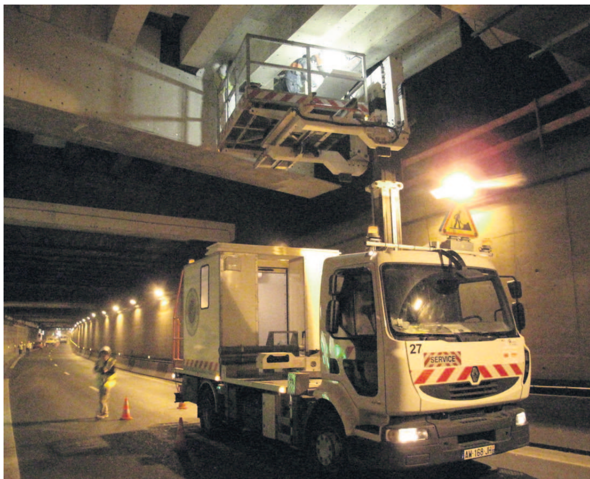
LA DÉFENSE, JEUDI SOIR. Quatre nuits par semaine, le tunnel de l'A 14 est interdit à la circulation et se transforme en un énorme chantier de 4 km. Entre 150 et 200 personnes y travaillent. Elles fixent des plaques de silicate de calcium avec des ventouses de vitrier (en haut à gauche). Ces plaques sont découpées sur place (ci-dessus à gauche) et posées à l'aide de camions équipés de plates-formes élévatoires (ci-dessus à droite) au plafond et sur les murs en béton. Les travaux, dont le but est de faciliter l'intervention des professionnels et de renforcer la sécurité des automobilistes, devraient être terminés fin octobre 2012. (LP/F.H.)
